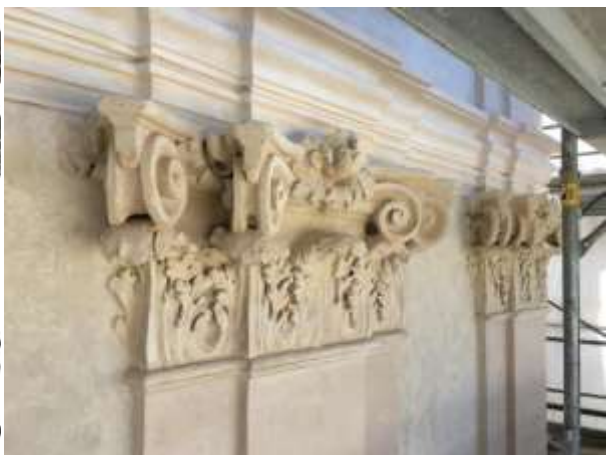
FACCIATA PRINCIPALE POST restauro Recupero particolari originali e parziale integrazione
