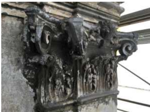
FACCIATA PRINCIPALE – Particolari ANTE restauro Croste nere trattate con impacchi di AB57
