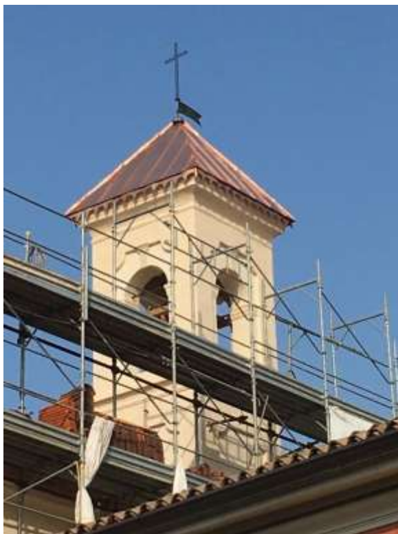
Campanile dopo l'intervento
