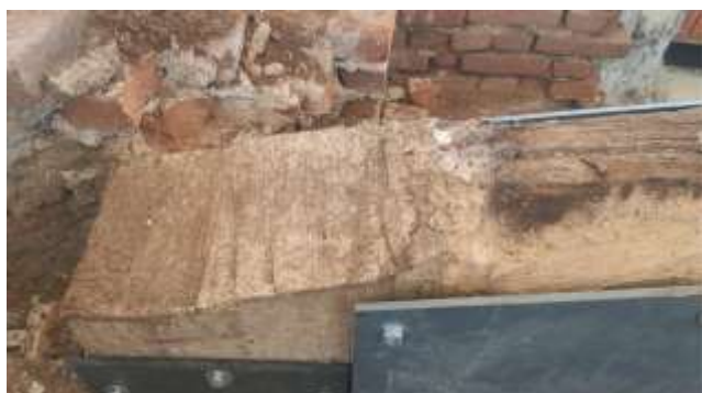
Consolidamento dei punti di appoggio delle teste dei travi-catena a contatto con le murature e rinforzo con barre di metallo
